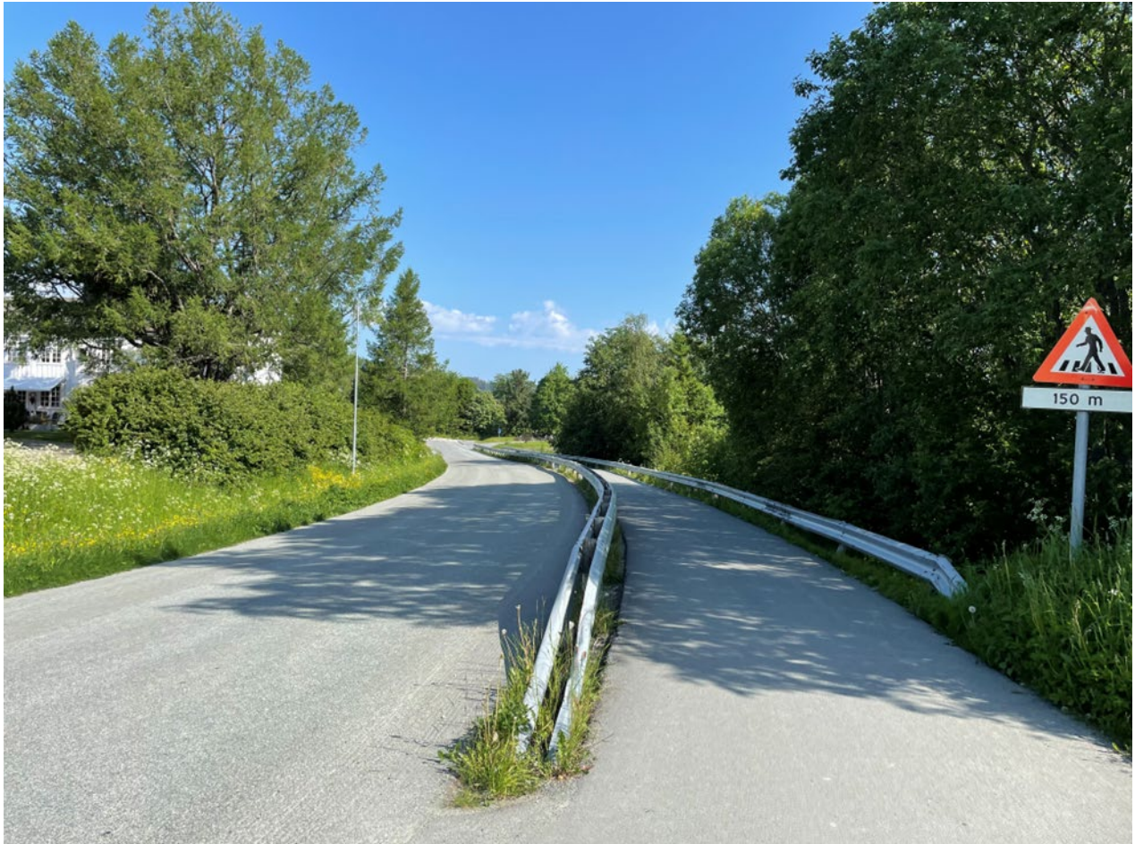
Figur 4.8 Gimsvegen sett mot nord. (Foto: NIRAS).
